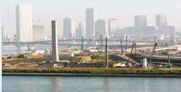
東京五輪関連工事の現場（臨海部）
