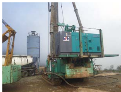
タイ（左）とベトナムの工事現場で使用する当社建機 Kanamoto construction equipment being used at worksites in Thailand (left) and Vietnam
