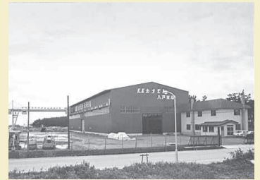
八戸支店(現・八戸機械整備センター)
