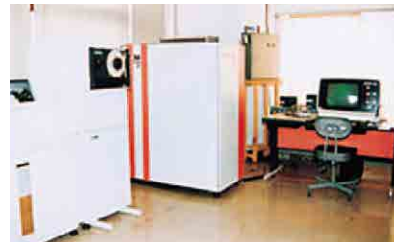
当時の電算室機械室
