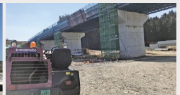
岩手県九戸郡野田村の橋梁上部工事 Noda-mura Bridge Superstructure Work in Kunohe, Iwate
