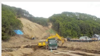
北海道勇払郡厚真町の法面復旧工事 Atsuma Slope Restoration in Yufutsu, Hokkaido
