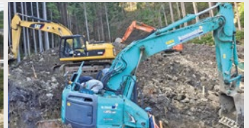
広島県山県郡安芸太田町の深沢外砂防堰堤工事 Akita-cho Mountain Stream Check Dam Construction in Yamagata, Hiroshima
