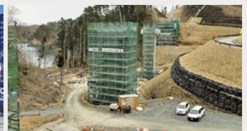
宮城県牡鹿郡女川町の橋梁下部工事 Onagawa-cho Bridge Superstructure Work in Oshika, Miyagi
