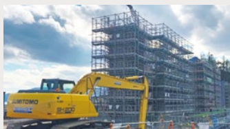
岩手県陸前高田市の防潮堤工事 Tide Embankment for the City of Rikuzentakata, Iwate
