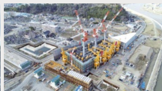
宮城県石巻市の排水ポンプ場建設工事 Drainage Pump Station Construction in Ishinomaki City, Miyagi
