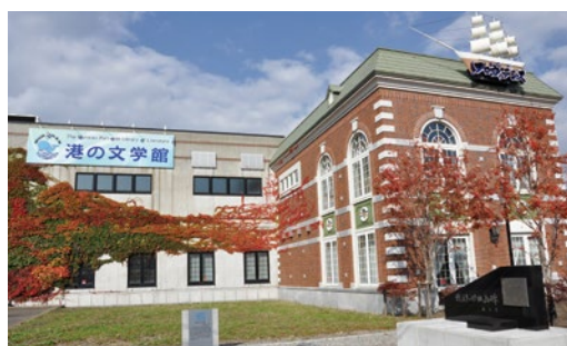
北海道室蘭市に無償貸与している旧ビアレ스토랑「プロヴィデンス」 Former Providence Beer Hall Provided to Muroran City in Hokkaido Free of Charge
