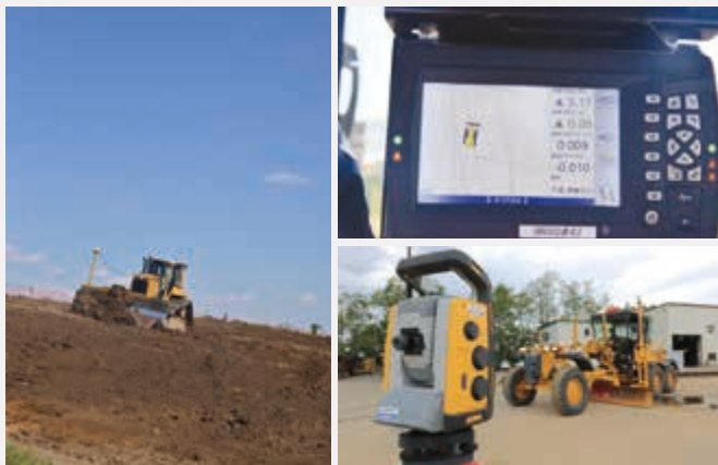
3 DMCや3 DMGを使った情報化施工 Digital Construction Using 3DMC and 3DMG
