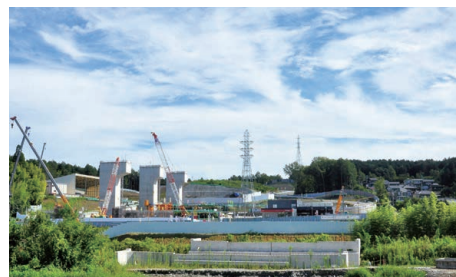
リニア中央新幹線 岐阜駅建設現場
