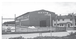
八戸支店 (現・八戸機械整備センター)
