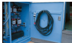
リモコンボックス、リモコンコード、吊りフック
