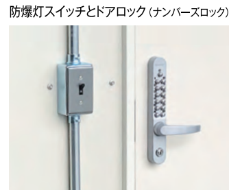
防爆灯スイッチとドアロック(ナンバーズロック)
