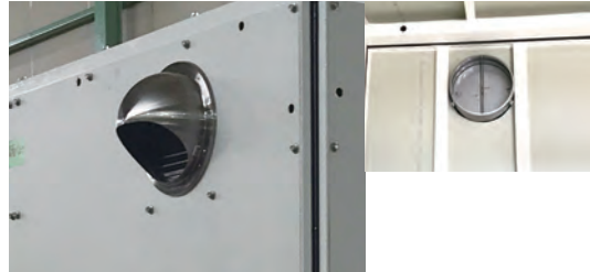
温度ヒューズ付き防火ダンパー・排気ダクト(エルボ)
