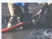
▲しゅんせつ泥土吸引
