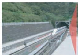
鉄道施設／侵入検知
