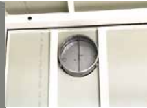
温度ヒューズ付き防火ダンパー・排気ダクト（エルボ）
