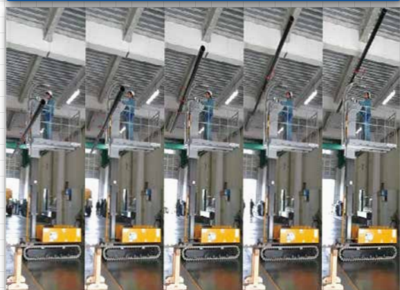
配管荷揚げイメージ
