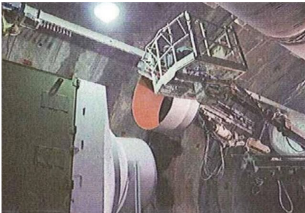
曲がり管設置状況
