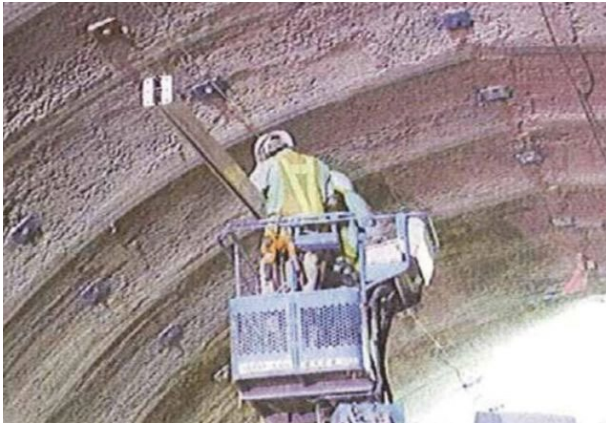
レール設置状況
