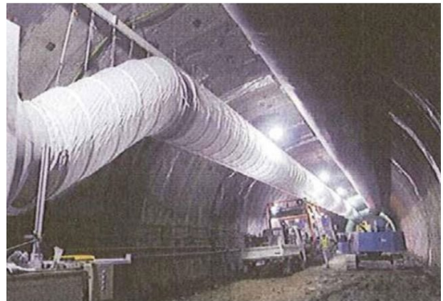
伸縮風管接続完了
