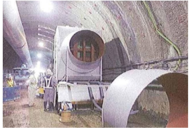
集塵機接続管の設置
