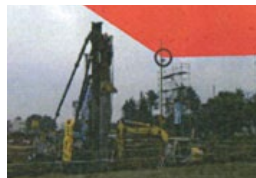
高圧線直下作業／空頭検知
