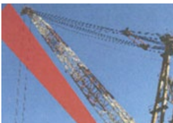
複数クレーン作業／衝突検知
