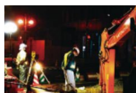
夜間工事現場
