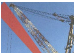
複数クレーン作業/衝突検知
