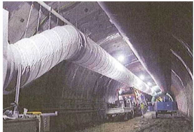
伸縮風管接続完了
