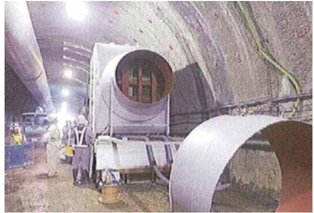
集塵機接続管の設置
