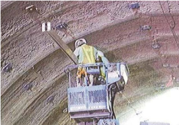
レール設置状況
