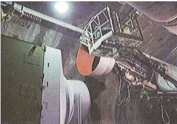
曲がり管設置状況
