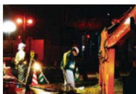
夜間工事現場
