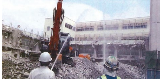
【散水作業現場】
