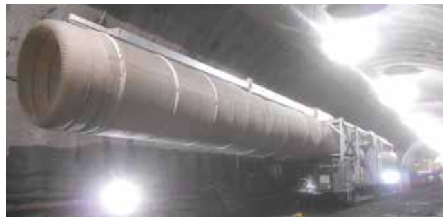
ECステーション (排出側から見る)
