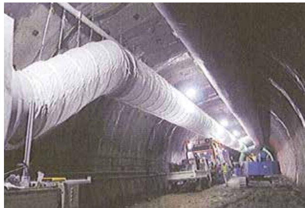
伸縮風管接続完了
