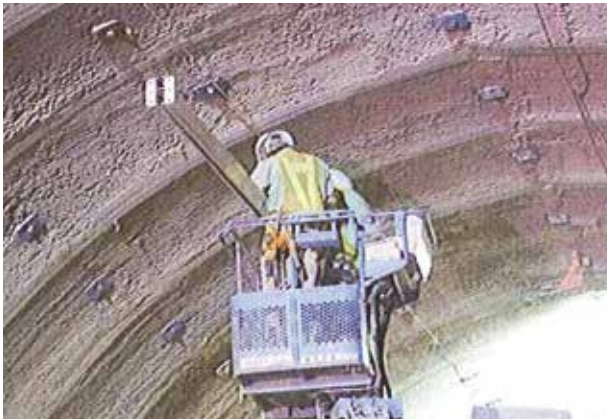
レール設置状況
