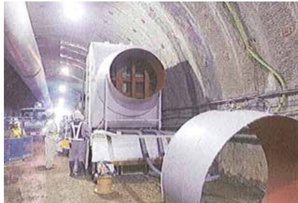
集じん機接続管の設置
