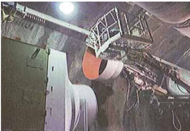
曲がり管設置状況
