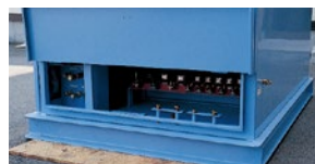
一次側キャブタイヤ取付部
