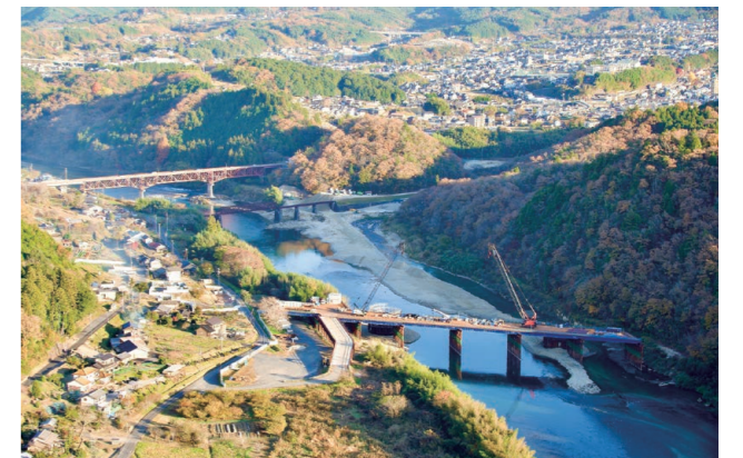
リニア中央新幹線・第一木曾川橋梁工事
